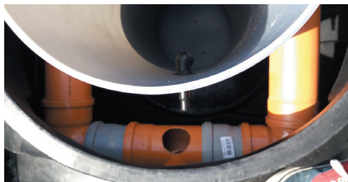
рисунок 2 Переливная система в стакане биофильтра «Rostok» Плюс
